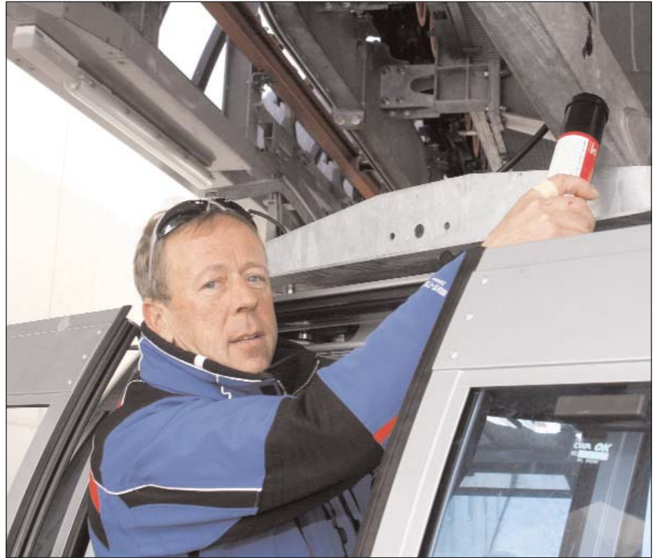
Betriebsleiter Peter Wettengl von den Bergbahnen Werfenweg schwört auf INTERFLON Food Grease LT2 und INTERFLON Fine Lube TF: „Seit wir das verwenden, kennen wir keine Probleme mit den langsam beweglichen Teilen mehr!“, lobt er. Foto: Si/Hinterseer
